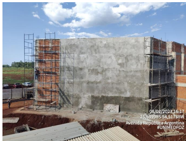
Foto 2 – Reboco e Fachada ACM – Fachada Principal
