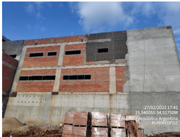
Foto 25 – Reboco - Fachada Fundos
