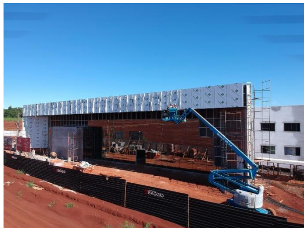
Foto 3 – Pele de Vidro e Fachada ACM – Fachada Principal
