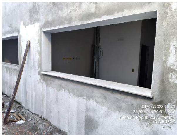
Foto 13 – Instalação de Contramarco, Pingadeiras e Janelas
