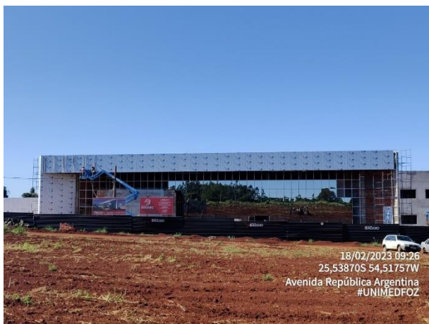
Foto 6 – Pele de Vidro e Fachada ACM – Fachada Principal
