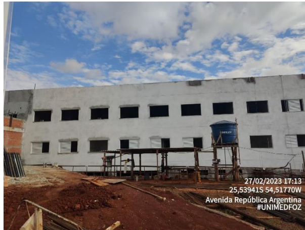
Foto 23 – Selador Externo – Fachada Principal
