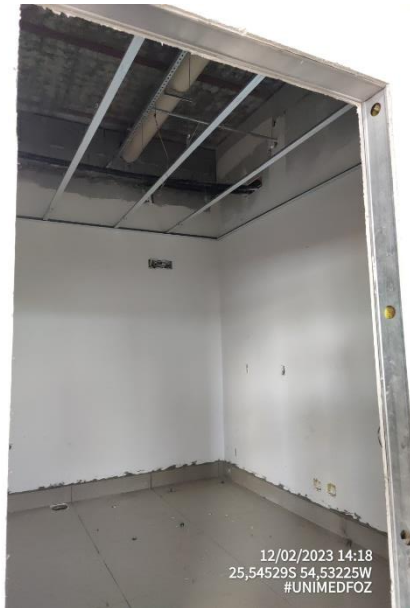
Foto 20 – Drywall – Estruturação de Forro
