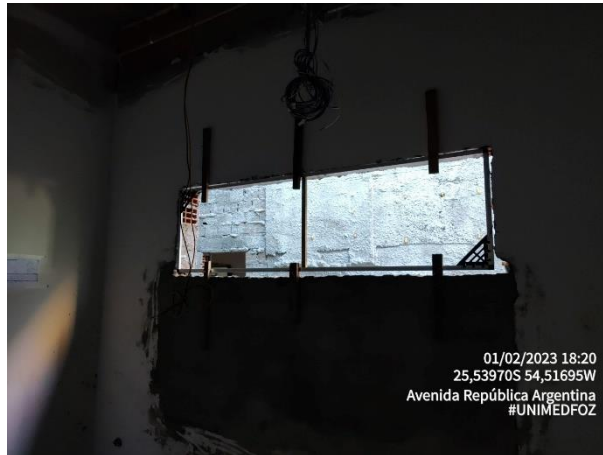
Foto 12 – Instalação de Contramarco, Pingadeiras e Janelas
