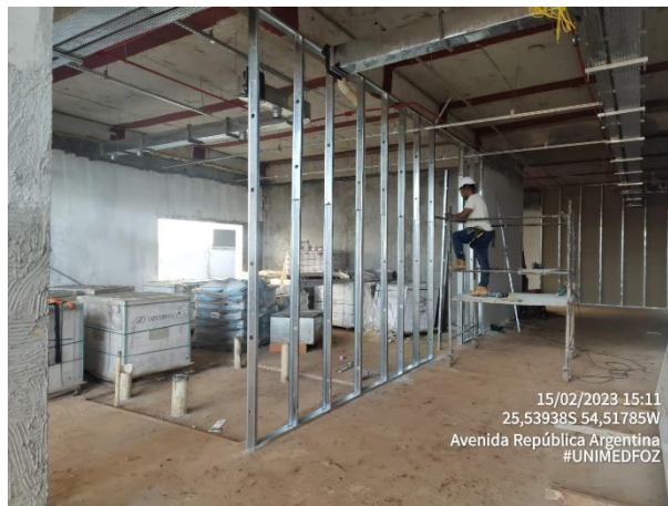
Foto 21 – Drywall – Estruturação de Paredes
