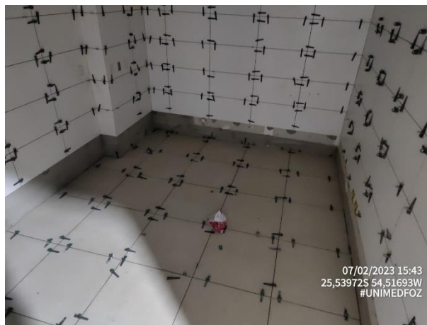
Foto 8 – Acabamentos - Revestimento Cerâmico
