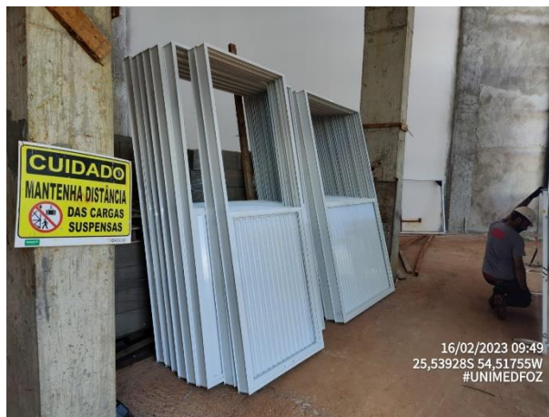
Foto 14 – Instalação de Contramarco, Pingadeiras e Janelas
