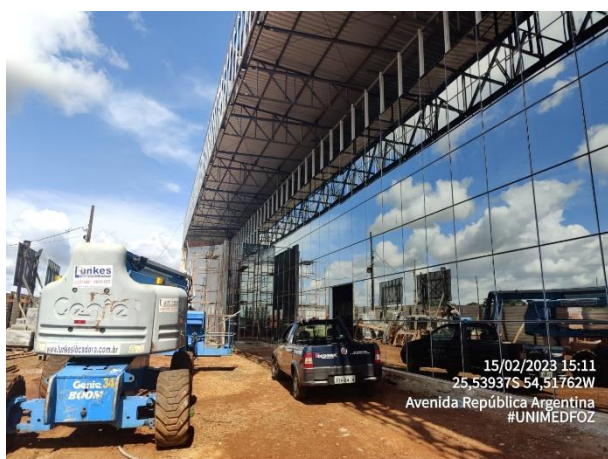
Foto 5 – Pele de Vidro e Fachada ACM – Fachada Principal
