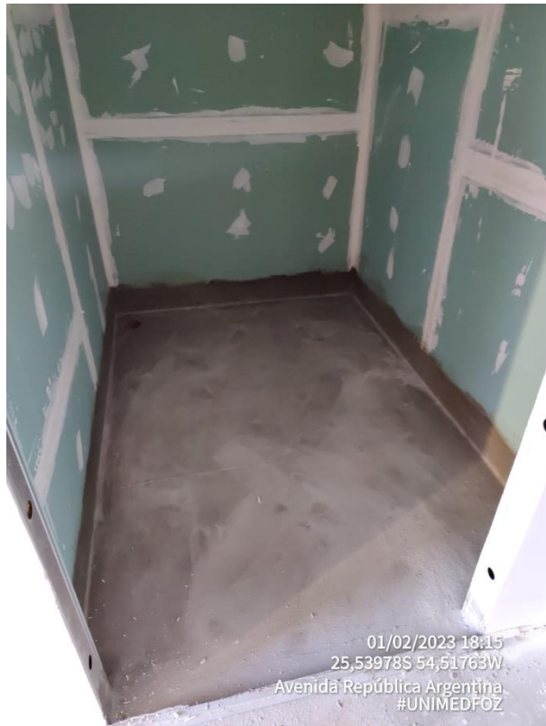
Foto 19 – Impermeabilização – Piso
