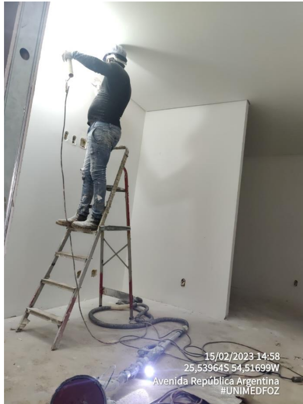
Foto 18 – Acabamentos – Pintura Parede e Teto
