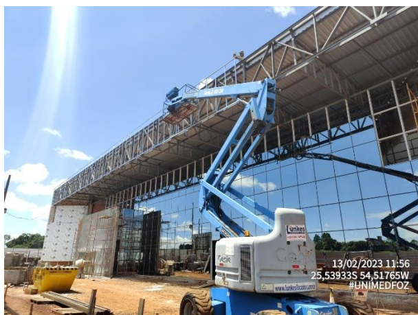
Foto 4 – Pele de Vidro e Fachada ACM – Fachada Principal
