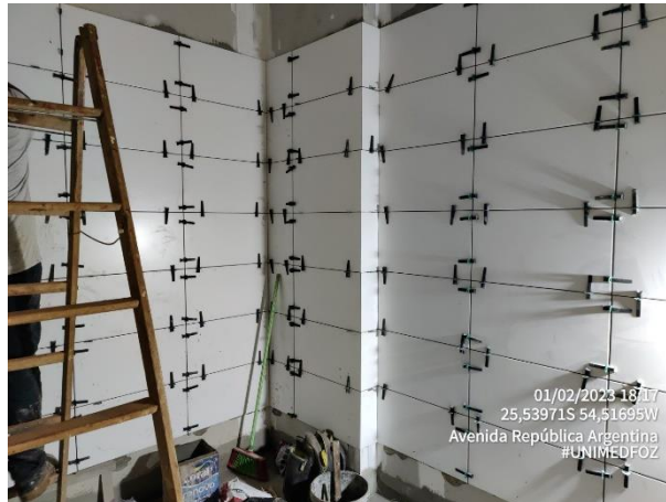
Foto 7 – Acabamentos - Revestimento Cerâmico
