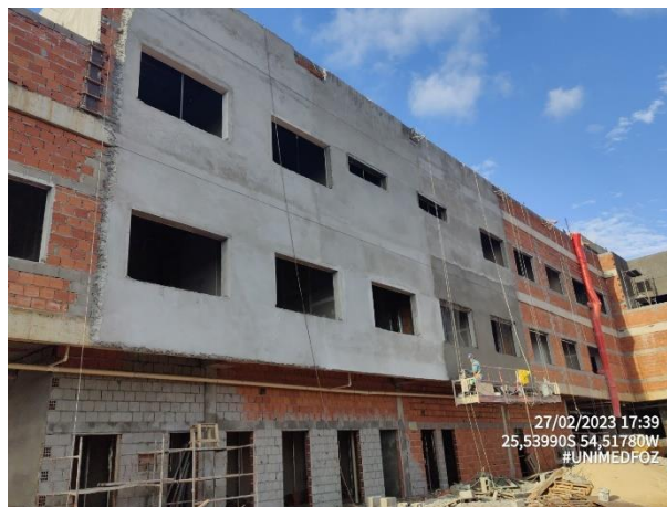
Foto 24 – Reboco - Fachada Fundos
