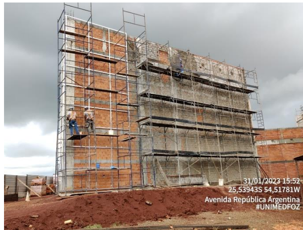
Foto 1 – Reboco e Fachada ACM – Fachada Principal
