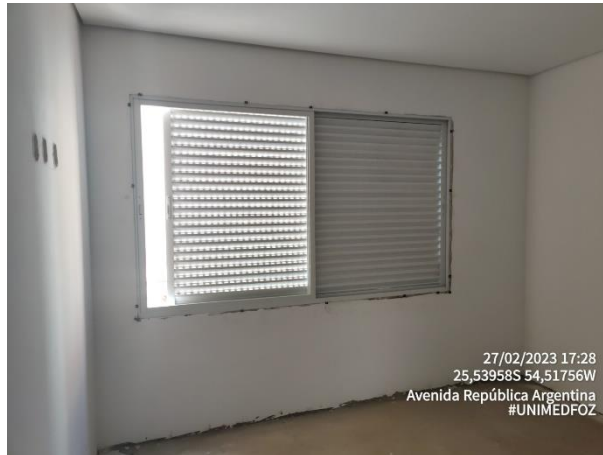
Foto 15 – Instalação de Contramarco, Pingadeiras e Janelas
