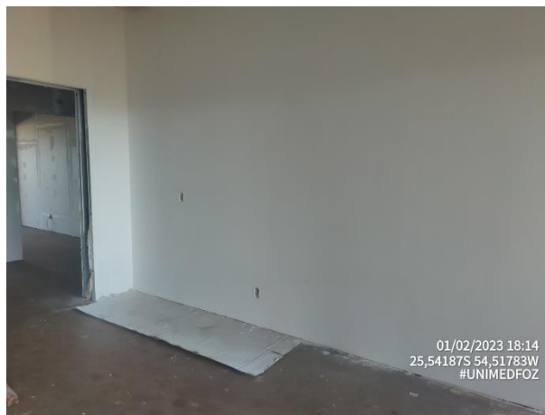
Foto 16 – Acabamentos – Pintura Parede e Teto
