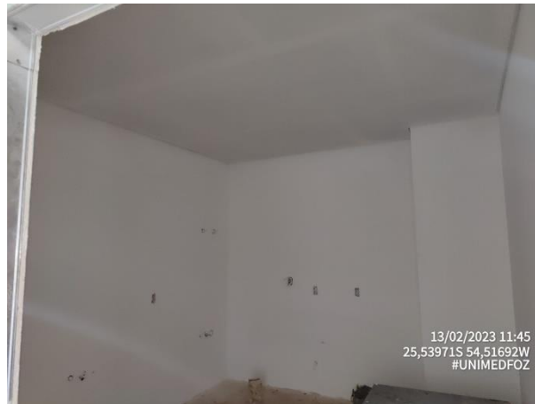
Foto 17 – Acabamentos – Pintura Parede e Teto
