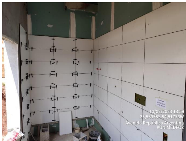
Foto 9 – Acabamentos - Revestimento Cerâmico
